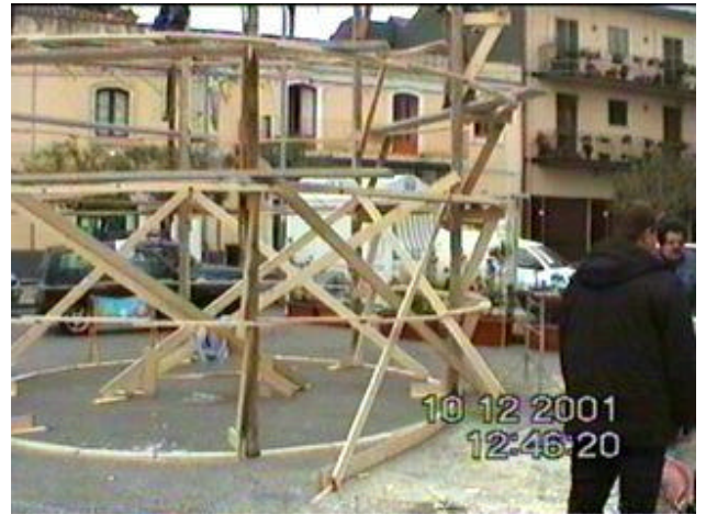
10-12-2001 realizzazione della struttura portante
